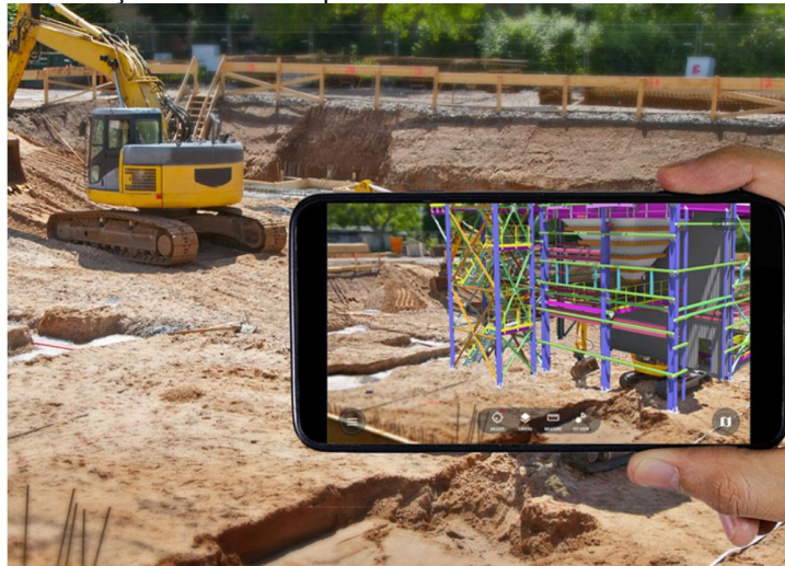
Figura 8 - Visualização da Estrutura aplicada no canteiro de obras utilizando a Realidade
